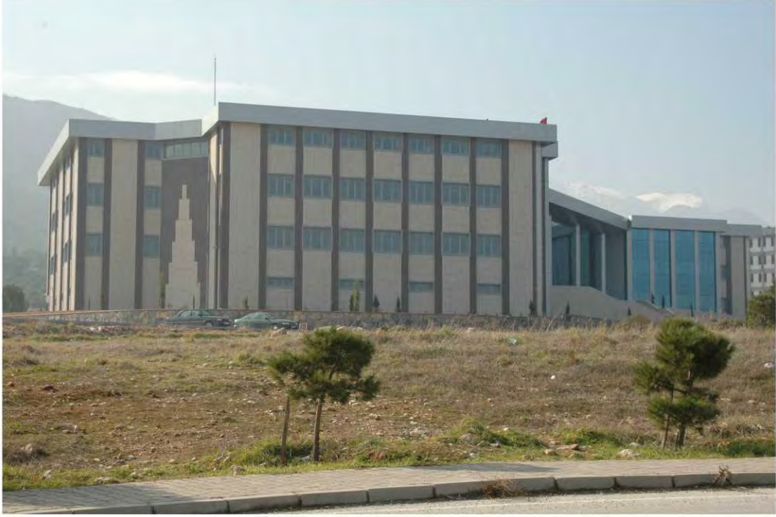
Rektörlük binası doğu cephesinin genel görünümü
