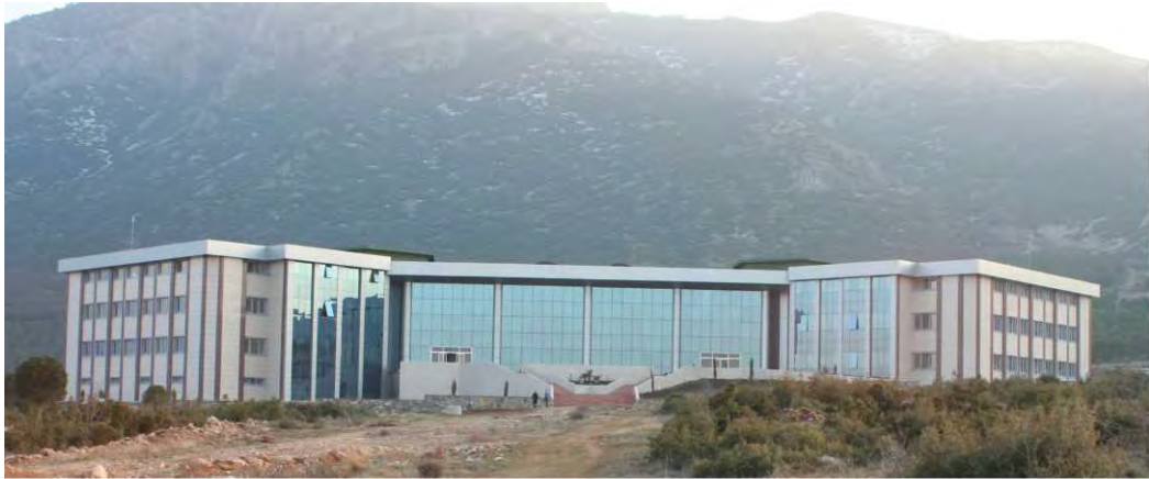
Rektörlük binası kuzey cephesinin genel görünümü
