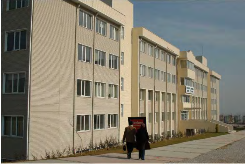
Mühendislik ve Teknik Eğitim Fakültesinin güney cephesinin genel görünümü
