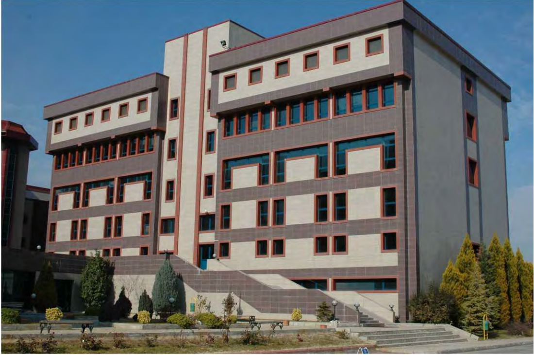
Morfoloji Binası kuzey bloğunun genel görünümü
