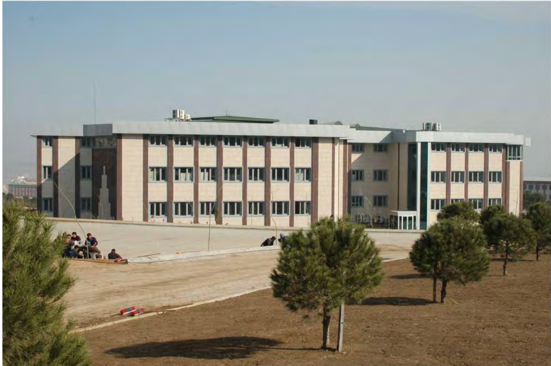
Rektörlük binası güney cephesinin genel görünümü
